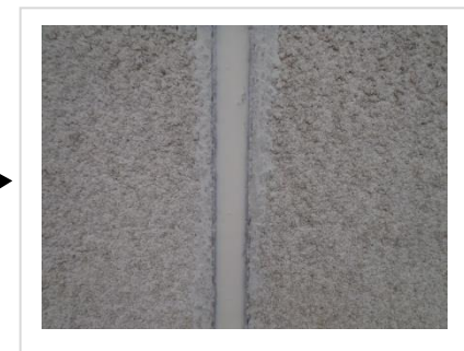
コーキング（施工後）
