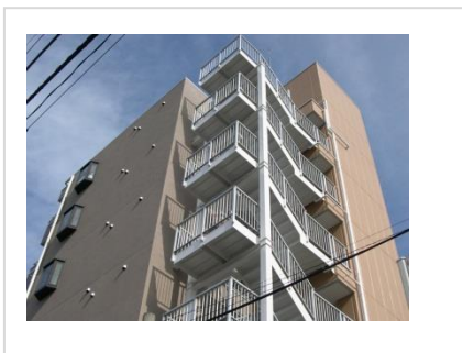
施工例（鉄板下地）
