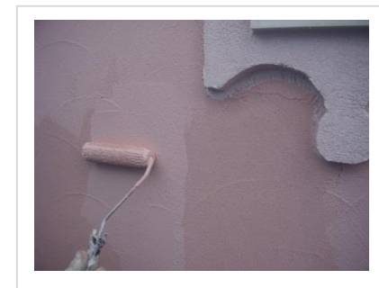
施工例（モルタル系下地）
